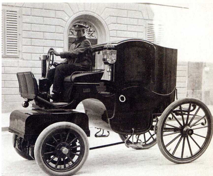
Sopra, una carrozza con una applicazione di motore elettrico effettuata dalle Officine Galileo.
